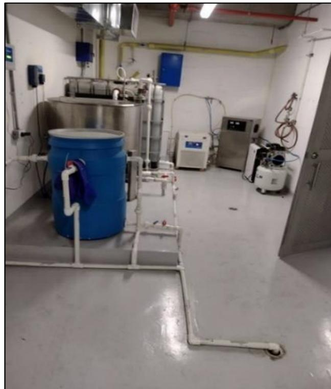
Figura 17. Fotografía del proceso de ozonización instalado en el Centro Médico Imbanaco
