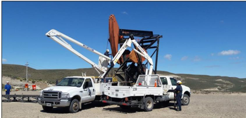
Figura 10. Dos cuadrillas en conjunto realizando cambio de estrobo en cabeza de mula
