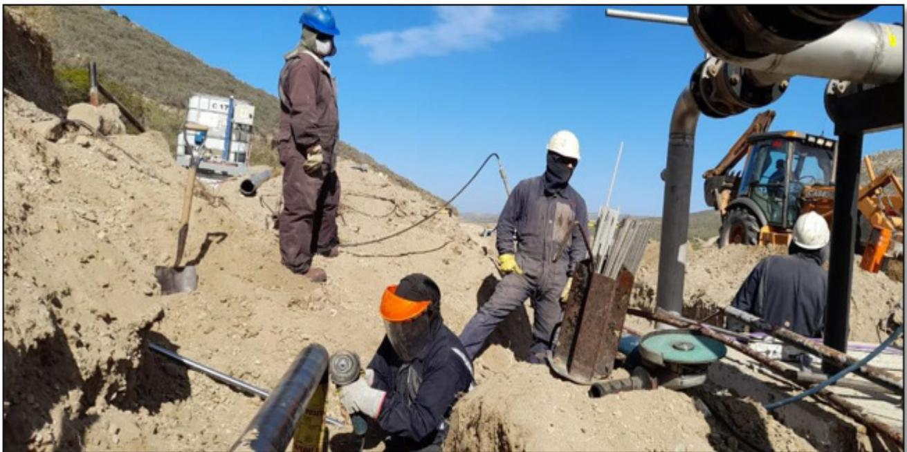
Figura 5. Operario se encuentra cepillando cañería de 4 con amoladora angular 750/115 mm
