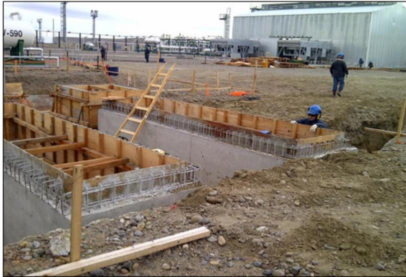
Figura 9. Encofrado de cámaras
