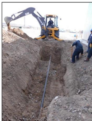
Figura 11. Cateo y excavación para reparación de línea de 2''
