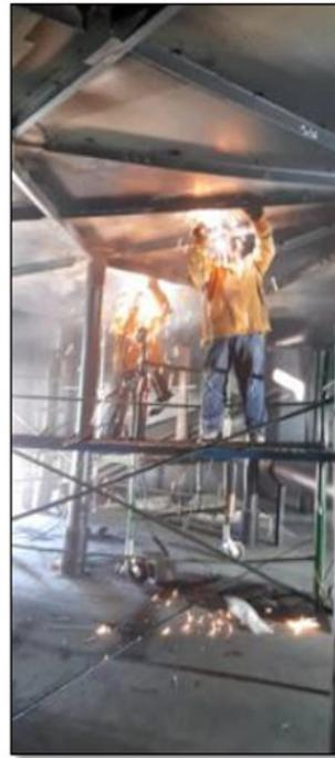
Figura 6. 4-5 Soldadura en espacio confinado con andamio en tanque cortador, planta sur
