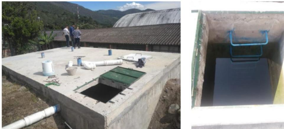
Figura 15. Tanque de Almacenamiento Nuevo
