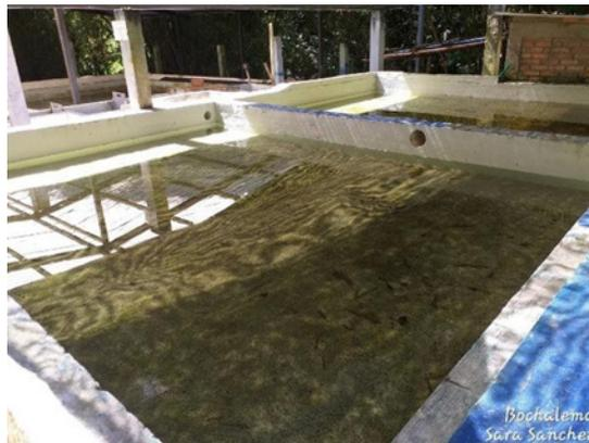
Figura 11. Filtro Rápido de Flujo Ascendente
