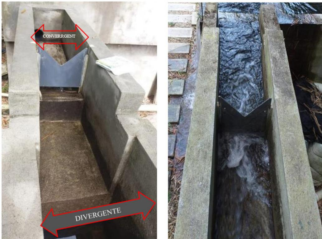
Figura 6. Tubería de Ingreso y Canaleta Parshall
