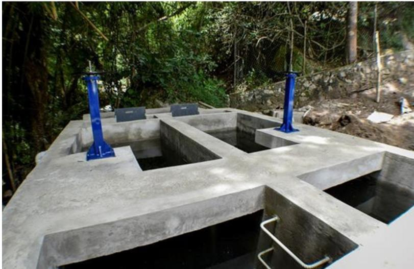
Figura 5. Estructura del Desarenador
