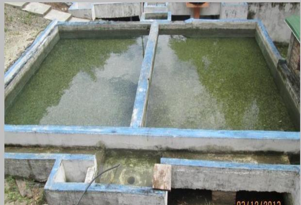
Tanque de almacenamiento Es de tipo enterrado Construido en concreto, tiene respiraderos, válvulas de entrada salida y de purga. Las dimensiones son 8,80 m de largo, 8,70 m ancho y 3,40 m de profundidad. (260 m<sup>3</sup>). Evaluación de la capacidad (volumen total de almacenamiento útil de 230m<sup>3</sup>).<sup>(4)</sup>
