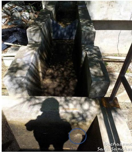
Figura 17. Ingreso de Agua a la Primera Cámara del Floculador
