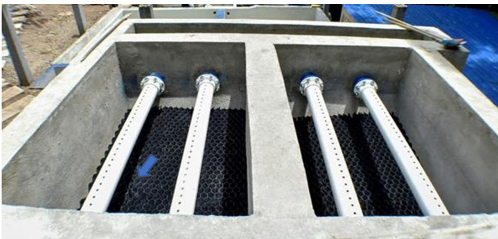
Figura 10. Sedimentador Laminar
